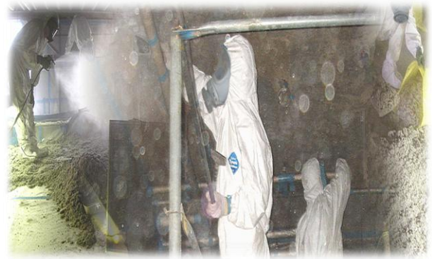
アスベスト除去作業の様子
